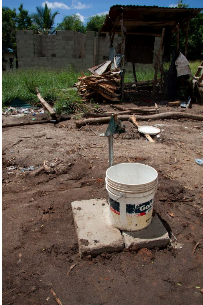
Eén van de aftappunten voor drinkbaar water van de nieuwe Glory waterleiding
